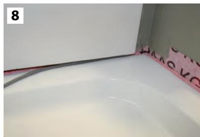
(DE) Nun den Butylklebestreifen an die Wand kleben. Der Wasserschutzstreifen muss dann mind. um 4 cm von der Fliese überdeckt werden.
